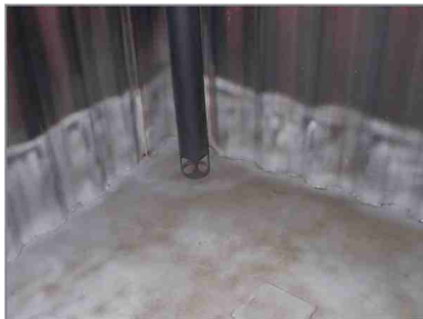
Unten: Teilgesandstrahlter keller-geschweißter Profilblechtank
