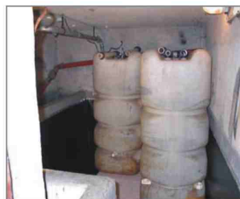
← Ölschlamm im kellergeschweissten Tank
