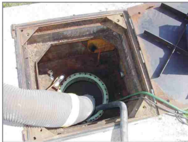
Oben: Sandstrahlentrostung eines unterirdischen Zylindertanks - Absaugen des Strahlstaubes
