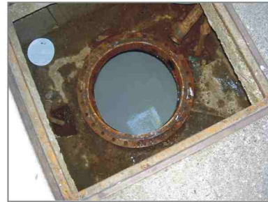
Oben: Beschichteter unterirdischer Zylindertank. Ansicht von oben durch die Einstiegsöffnung
