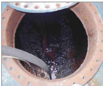
Ölschlamm verstopft Düsen und Filter →
