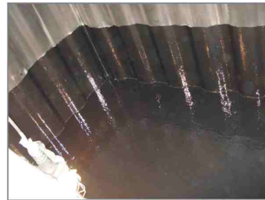
Unten: Teilbeschichteter keller-geschweißter Profilblechtank
